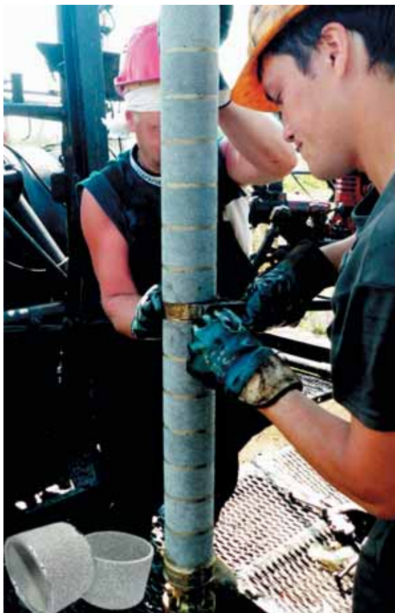
● Рис. 1. Монтаж фильтра ФВПР5-12-040-200-200.
